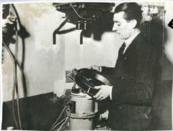
Frédéric montant les éléments d'une chambre de Wilson dont il conçut et mit au point un nouveau modèle à pression variable (1938)
