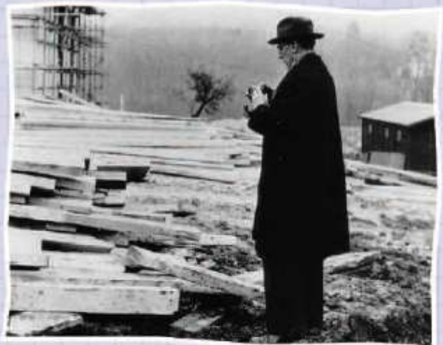
Frédéric prenant des photos du chantier de l'IPN d'Orsay, 1957
